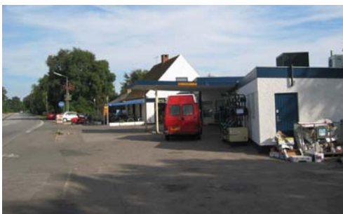
Krydset mellem Nyvej/Liselejevej/Møllevangsvej/Melbyvej, hvor der sker en omlægning og forskønnelse, der også fremhæver „hovedgaden“ og det centrale Asserbo samtidig med at øge trafikikkerheden
